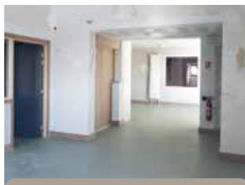
L'Espace Jeunes situé au 1 er étage du Centre Camille Claus est en phase finale de travaux. Reste à effectuer les peintures.
